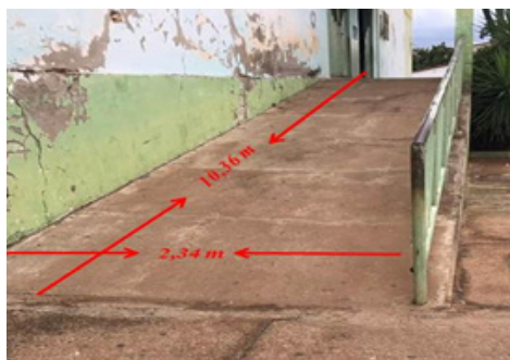
Figura 1- Rampa de entrada que dá acesso a área interna da escola
