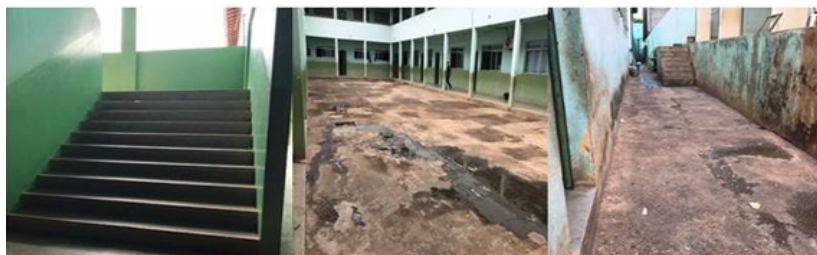
Figura 7 1ª imagem escada que dá acesso ao segundo andar da escola, 2ª imagem pátio ao ar livre, 3ª imagem escada que dá acesso a quadra de esportes da escola:
